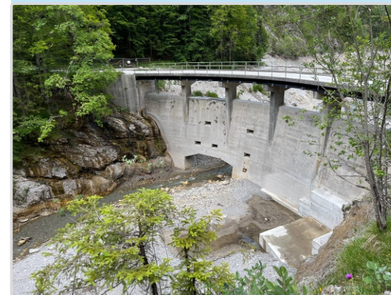
Stierschlagsperre an der Dürrach, Sylvensteinspeicher
