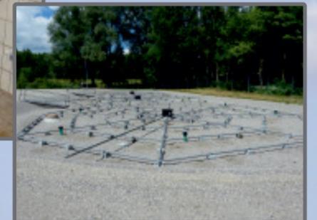
Kläranlage Rott mit Ausweichbodenfilter
