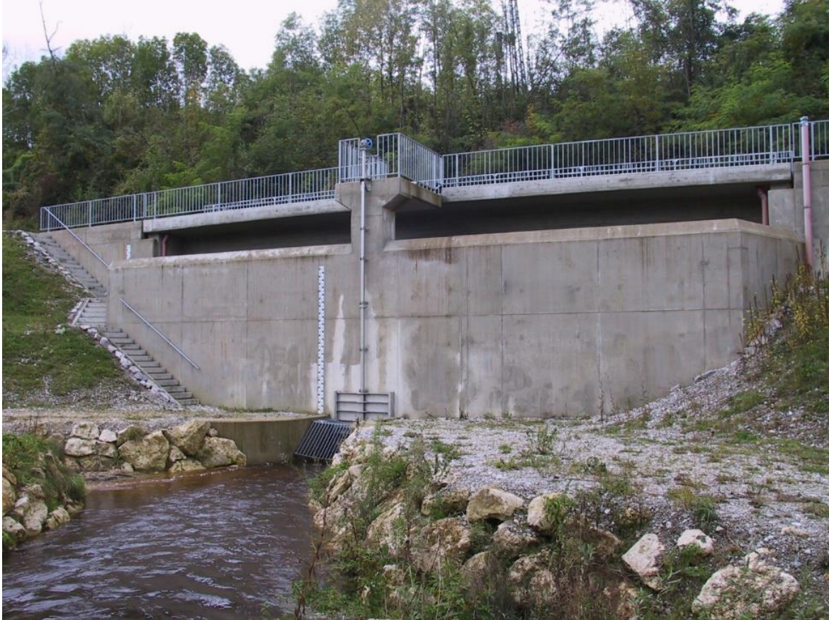
Abbildung 3: Stau-mauer mit Notentlastung am Hochwasserrückhaltebecken Wilzhofen
