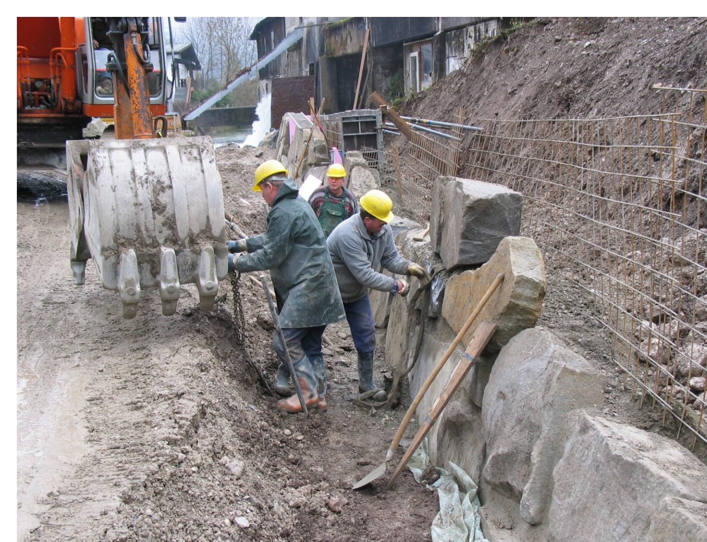
Dabei wurden große Steinplatten auf Beton gesetzt und verfugt. Die Wandneigung beträgt 5:1.
