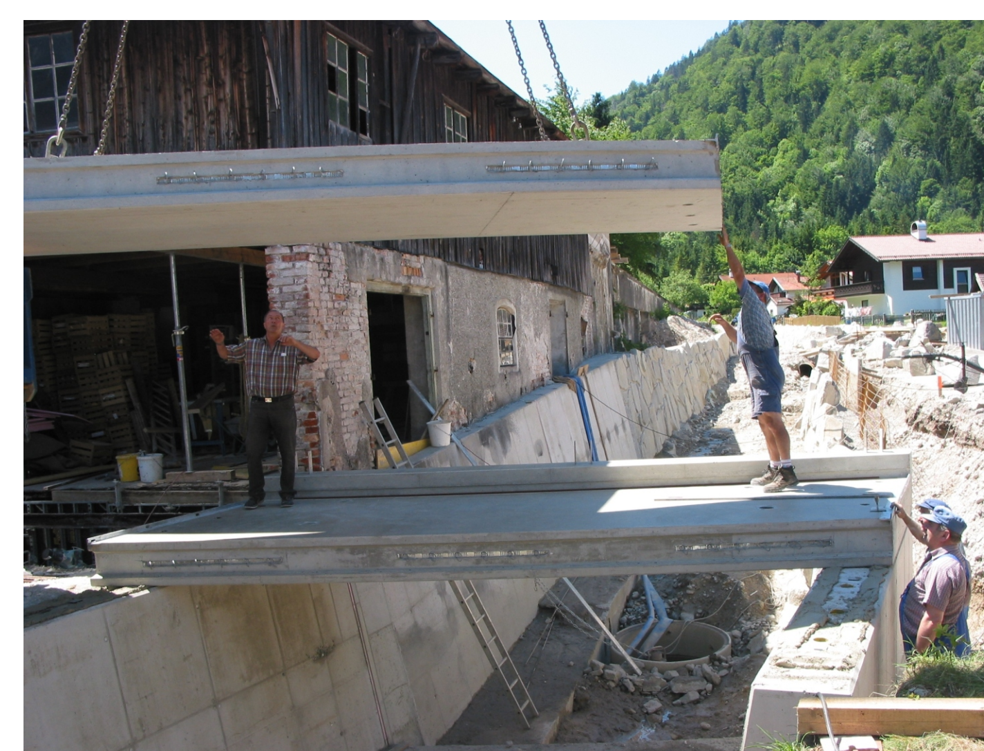
Mehrere Brücken mussten neu gebaut werden. Der Überbau wurde mit Fertigteilen, wie hier an der oberen Poettingerbrücke, hergestellt.
