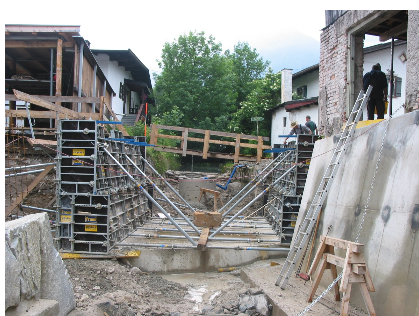
Die Widerlager der teils schiefwinkligen Brücken wurden von Arbeitern der Flussmeisterstelle Oberau vor Ort gefertigt.
