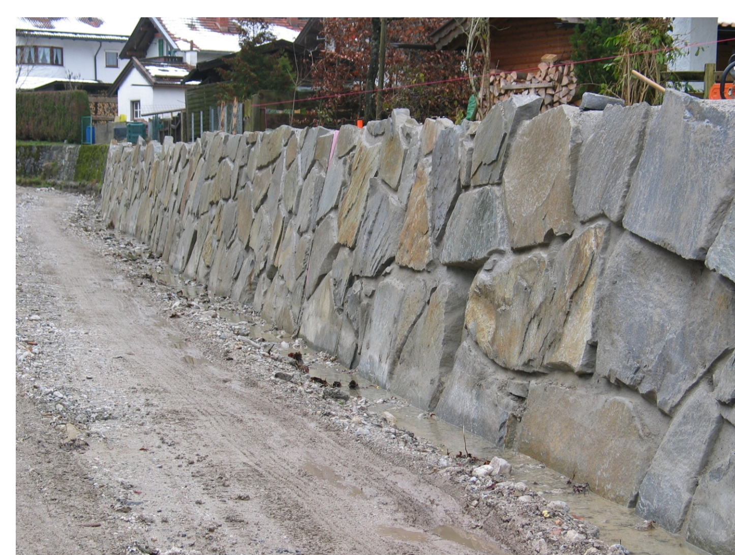
Aufgrund der beengten Verhältnisse konnte der Regelquerschnitt mit Böschungsneigungen von 1:1 nicht überall eingehalten werden. An den Engstellen wurde ein Trogprofil mit einer Schwergewichtsmauer hergestellt.
