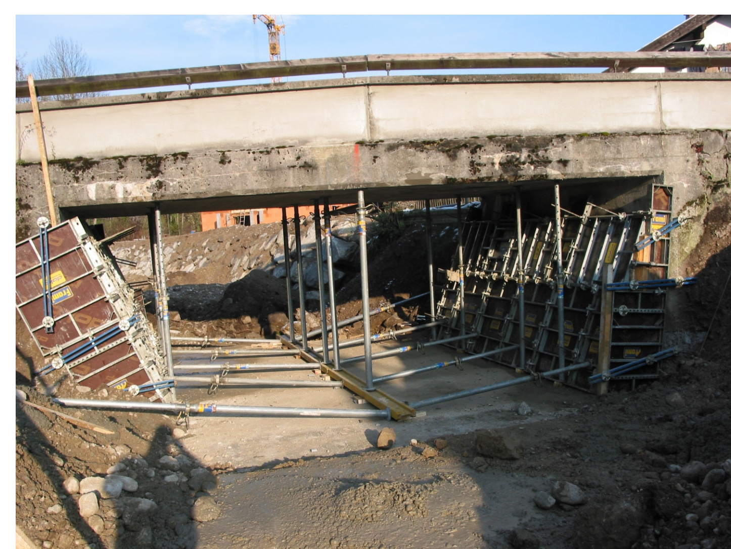
Eine besondere Herausforderung stellte die Unterfangung und Anpassung der vorhandenen Brückenwiderlager dar, wie hier an der Brücke zu den Stadtwerken.
