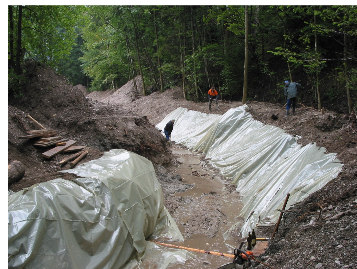
...streckenweise in einem neu gegrabenen offenen Gerinne.
