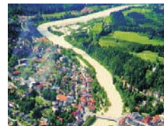
Bad Tölz, Jahrhunderthochwasser 1999 (nach der Dammerhöhung), keine Überschwemmungsschäden
