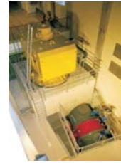
Kraftwerk KW1 Francis- Spiralturbine 2,6 MW
