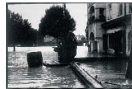
Bad Tölz, Hochwasser 1940 (vor dem Speicherbau), große Überschwemmungsschäden
