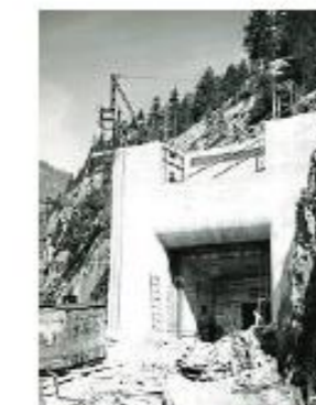
Der Grundablassstollen: Ein historisches Bild von der Baustelle. FOTO: DANNHORN
