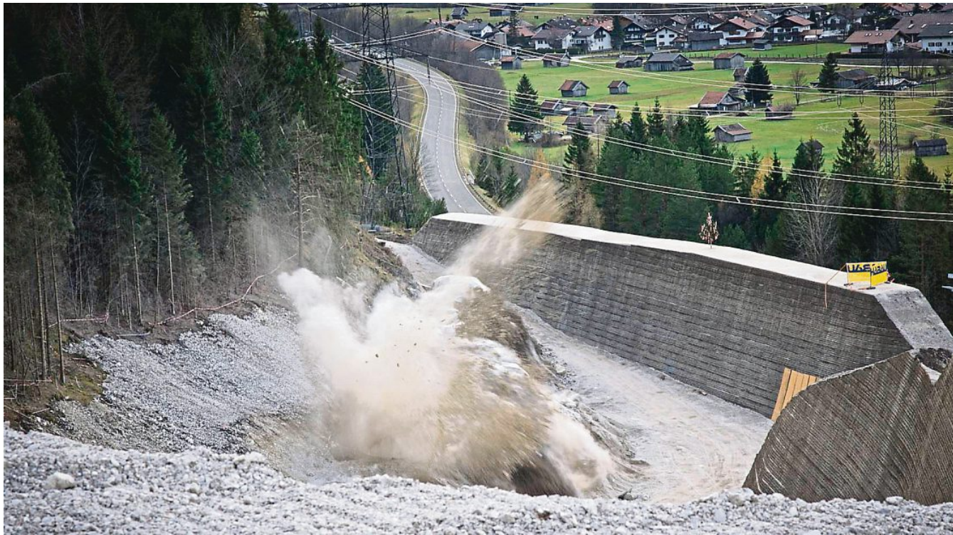
Der große Knall: Am unteren Damm detoniert bilderbuchmäßig die Sprengladung.
